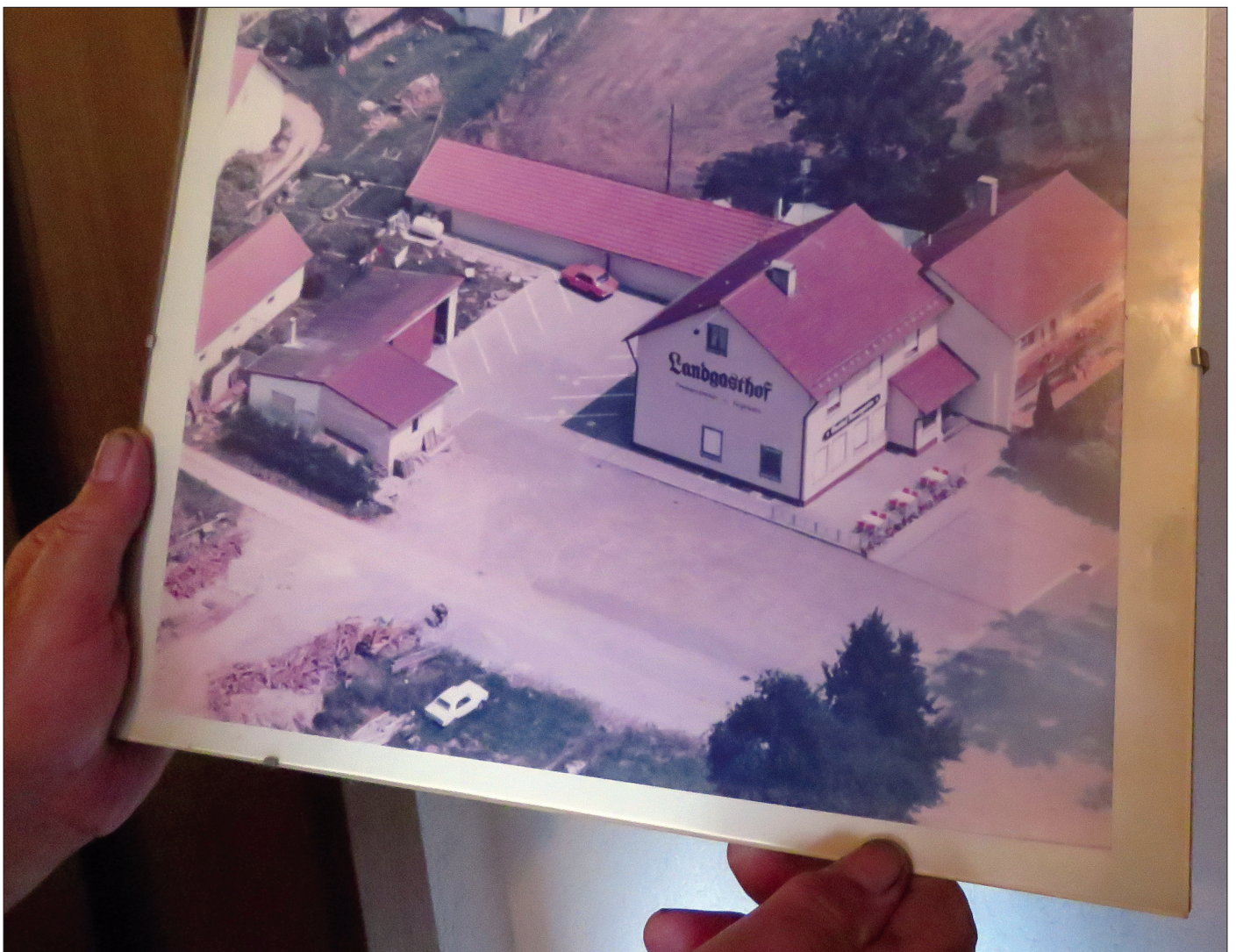
Der „Rosengarten“ Anfang der 1980er: Der Landgasthof ist, angedockt an das Wohnhaus von 1968, an die Stelle des alten „Rosengartens“ getreten; das lange Gebäude neben dem Auto ist die Kegelbahn.
