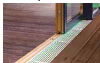
Ein Aluminium-Abdeckgitter in eleganter Optik sorgt für den ebenerdigen Übergang. Ihre Konstruktion garantiert eine hohe Dichtigkeit und Wärmedämmung
