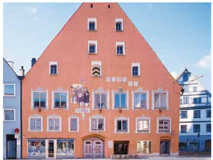
Heute: Das historische Gebäude fällt ins Auge. Fotos: Stadt Memmingen
